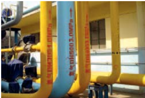
開展防腐工程
